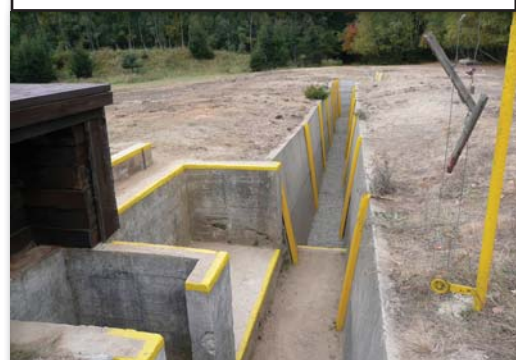
Stav po opravě
