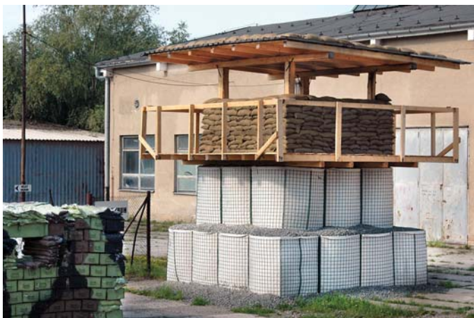
Hlavní strážní věž postavena s využitím zkušeností z Campu BMATT v květnu 2009 ...
