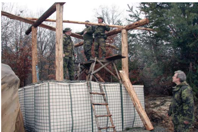
Kpt. Ing. Toriška při řízení stavby věže v sektoru Campu BMATT – březen 2009
