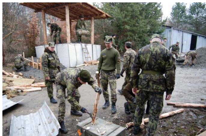
Dokončovací práce na věži č. 2 a ....
